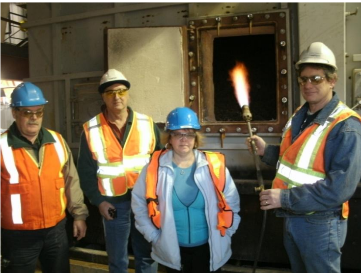
Mise en marche de la chaudière
